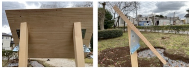
図6 立て看板の設置
