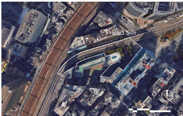
設計対象地：中央区立 数寄屋橋公園 Sukiyabashi Park, Chuo City, Tokyo
