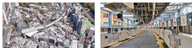
図1: 代々木八幡駅の鳥瞰写真と駅ホームの様子
